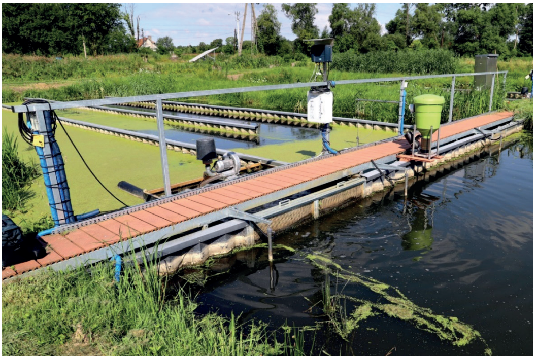
Rys. 7.27. Widok na kładkę serwisową.
