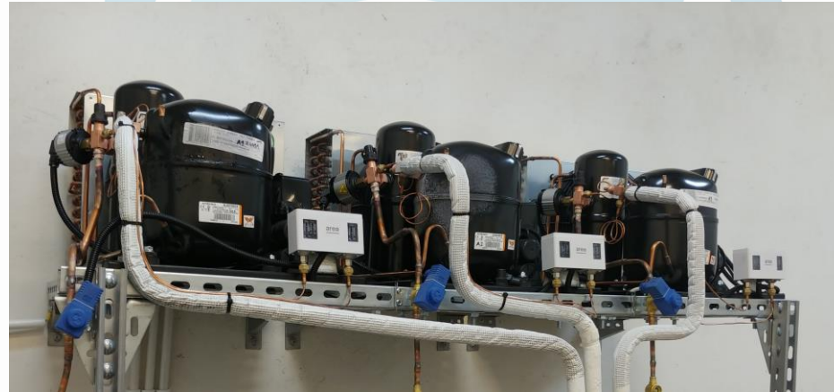
Agregat chłodzący
