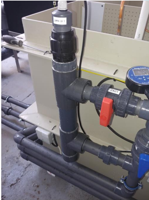
Dezynfekcja w rurociągu
